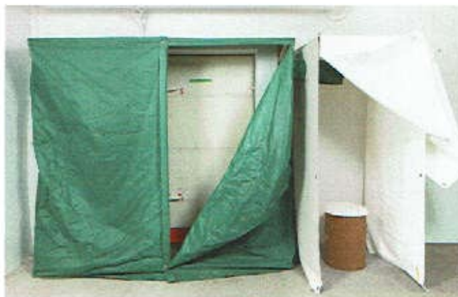
Monterbar luftsluss och torrklosett redo för bruk.
