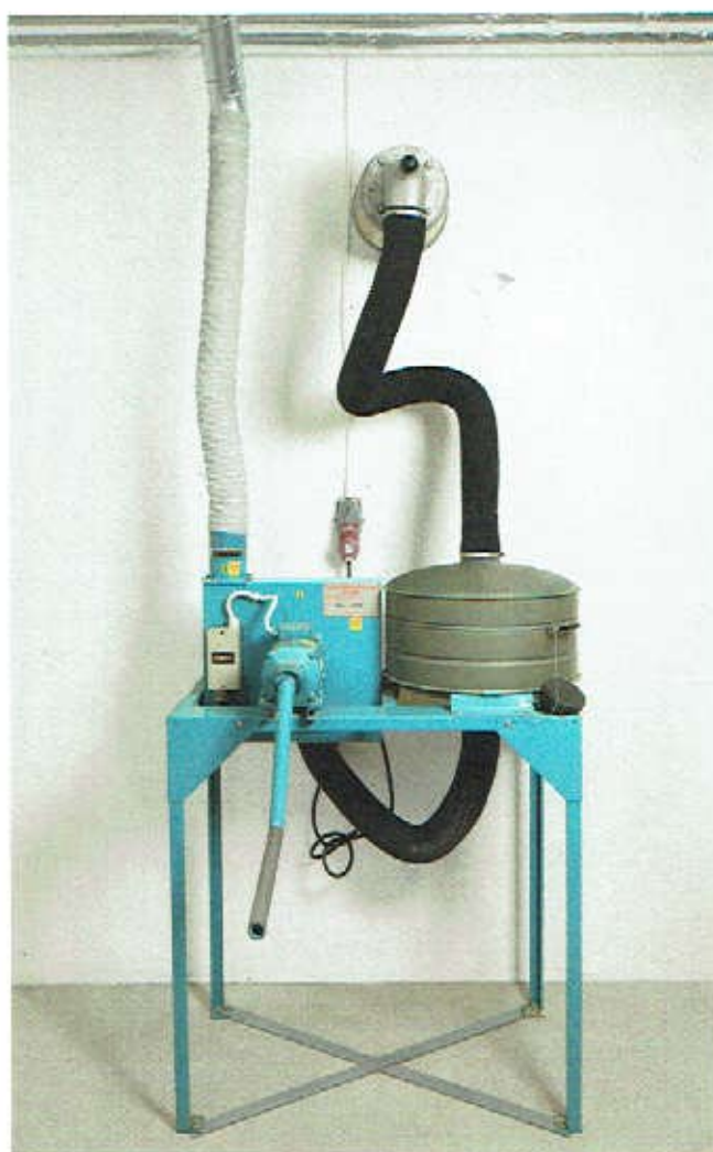
Ventilationsaggregat med elmotor och manuell vev. Filtret är av typen FAG. På väggens tilluftskanal har en stötvågsventil monterats. Från ventilen går en svart slang till filtrets ovansida och från undersidan av filtret går ytterligare en svart slang till själva fläkten. Från fläkten till skyddsrummets tilluftskanaler leder en ljusgrå slang. Alla slangar dras fast till rören med hjälp av slangklämmor.
