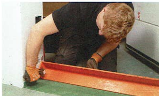
Där fast tröskel saknas används istället en monterbar tröskel.
