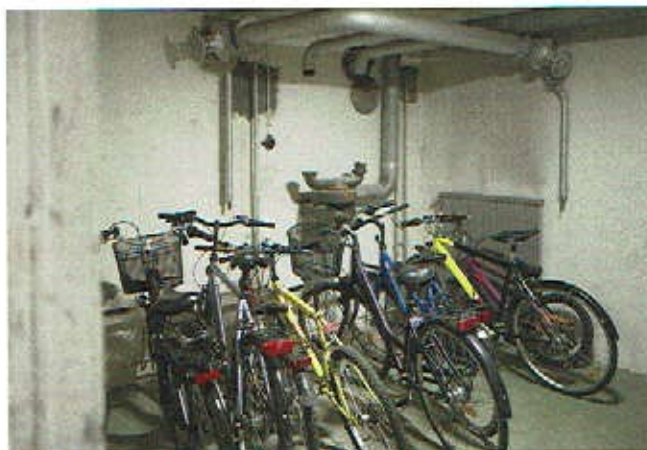
Allt som inte tillhör skyddsrummets grundläggande funktion ska rivas ned och flyttas ut.
