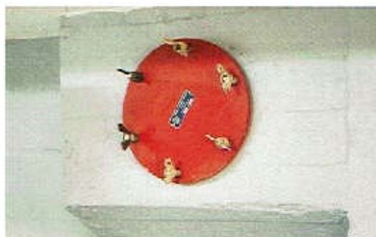
Splitterskydd monterat över ventil.
