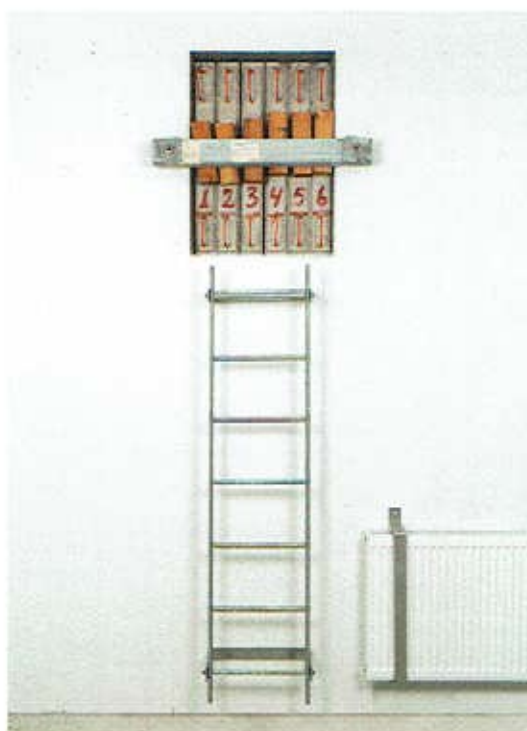
Reservutgång försedd med betongelement och regel.
